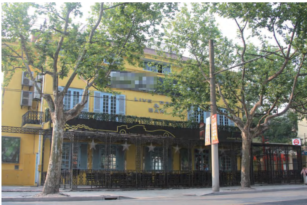
▲ 图 1-2-25 上海某商业建筑外立面
