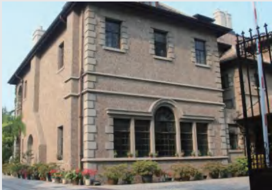
▲ 图 1-2-33 上海某建筑外墙
