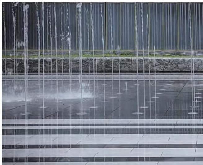
▲ 图 1-1-16 地面喷泉池面铺装
